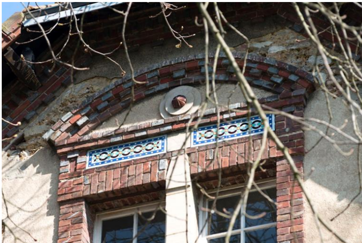
Frise de céramique d'une baie du rez-de-chaussée. Motif de quatrefeuille.
