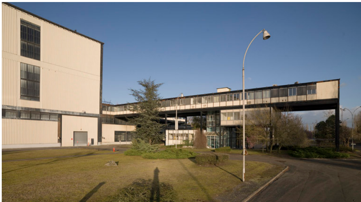
Vue extérieure. Bâtiment des bureaux
