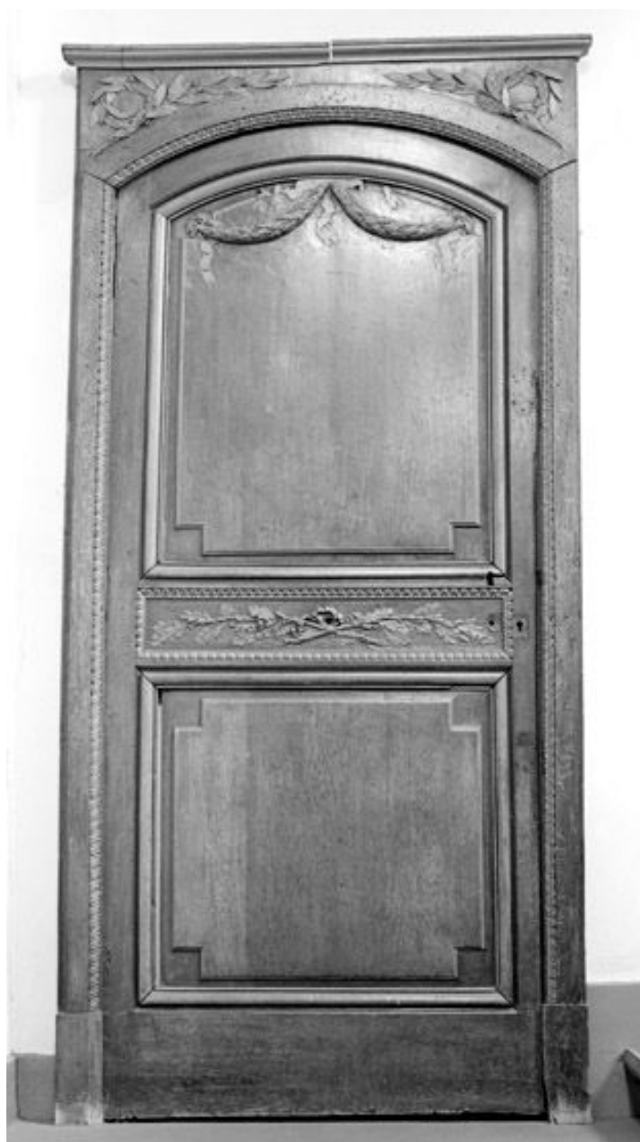
Vue d'ensemble de l'une des deux portes.
