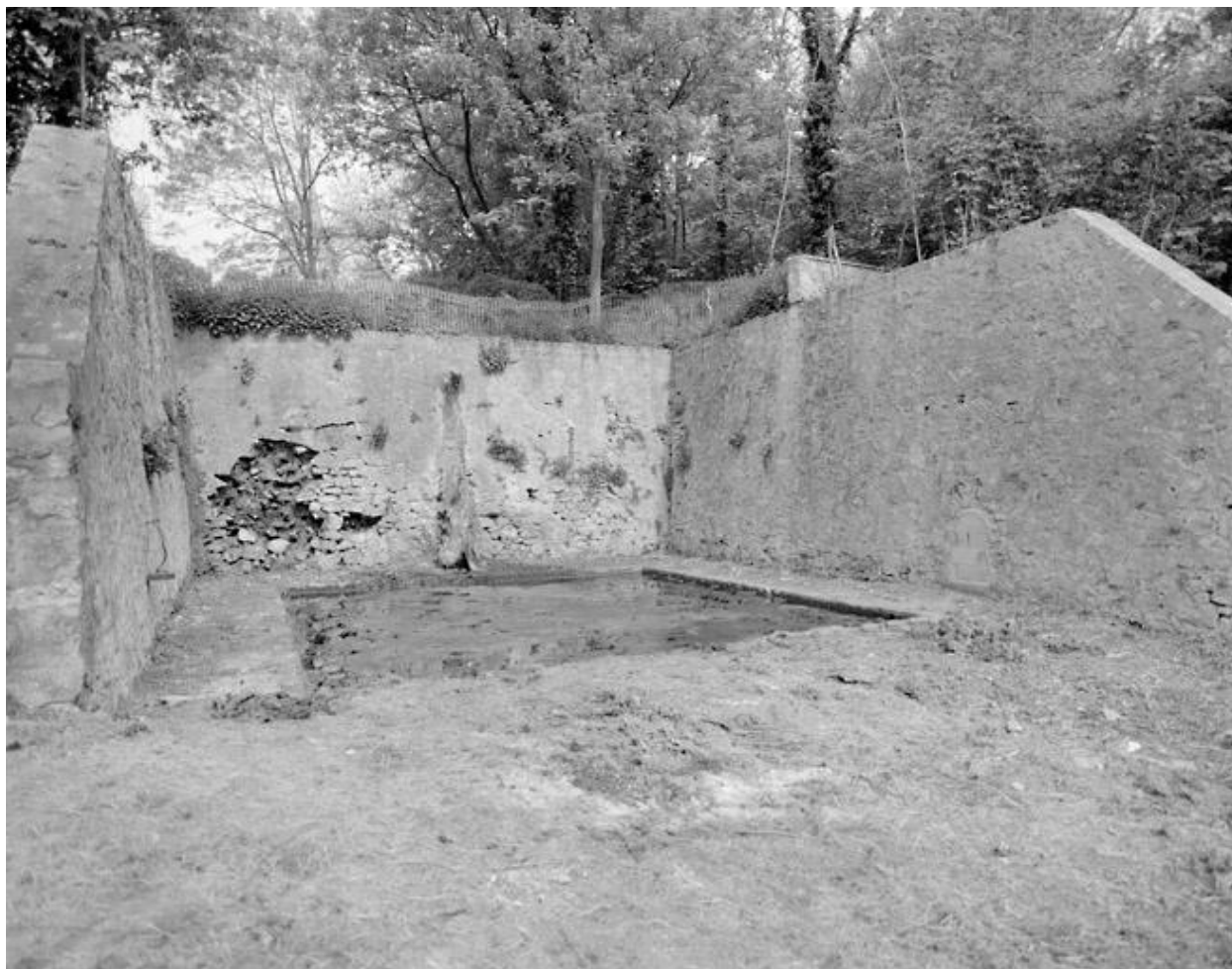
Le parc : bassin rectangulaire situé sous la terrasse du château, côté sud.
