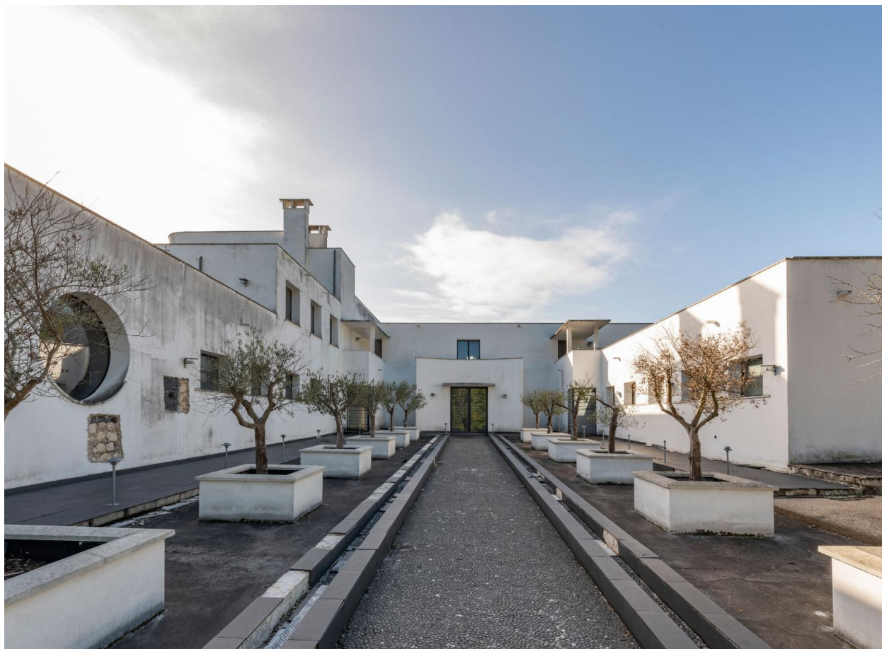
Villa Poiret, cour d'entrée, côté nord
