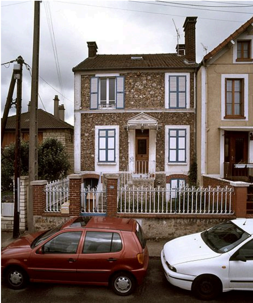
Façade principale ayant conservé sa modénature et son rocaillage.
