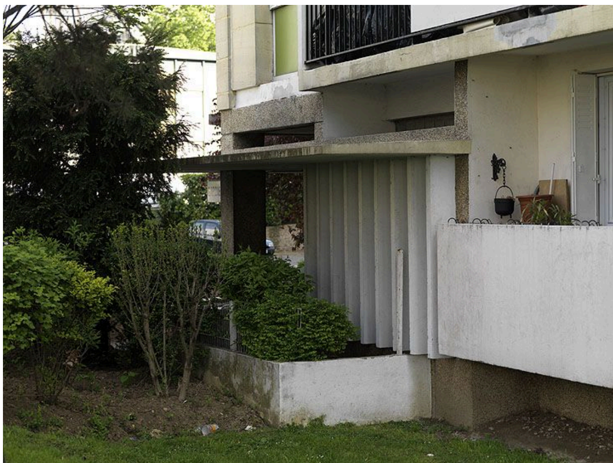
Vitry-sur-Seine, cité Verte, 36-32 rue Gagnée, 38-48 rue de la Fraternité. Vue du jardin.
