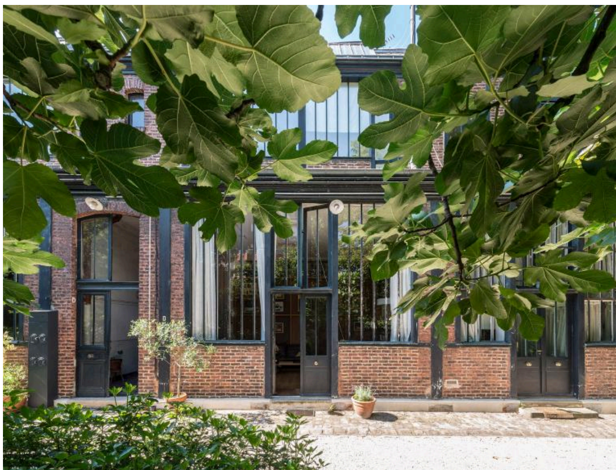
Vue de la façade de l'atelier de Francis Harburger (2)
