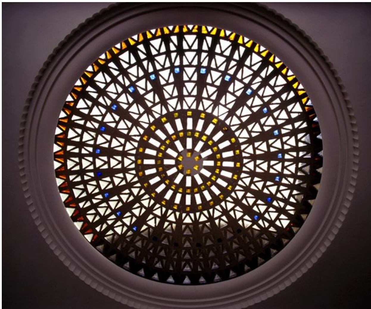
La verrière zénithale du vestibule.
