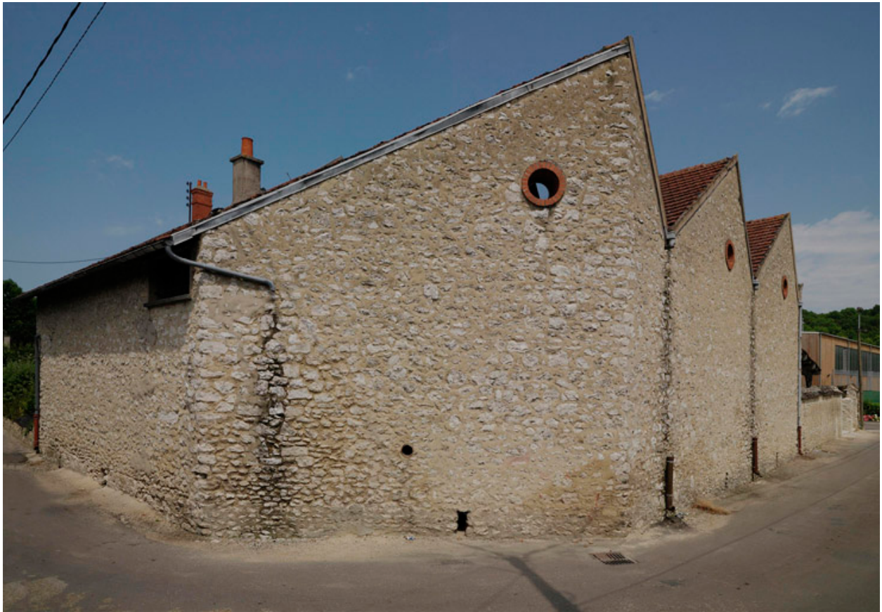
Vue extérieure de l'arriere du bâtiment.
