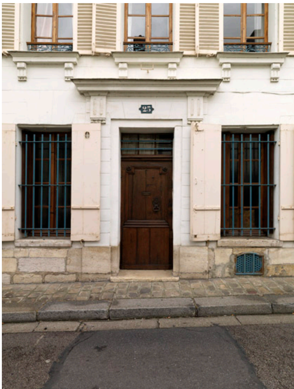
Maison de bourg, 25, rue Sangle. détail de la modénature de la porte piétonne et des baies.
