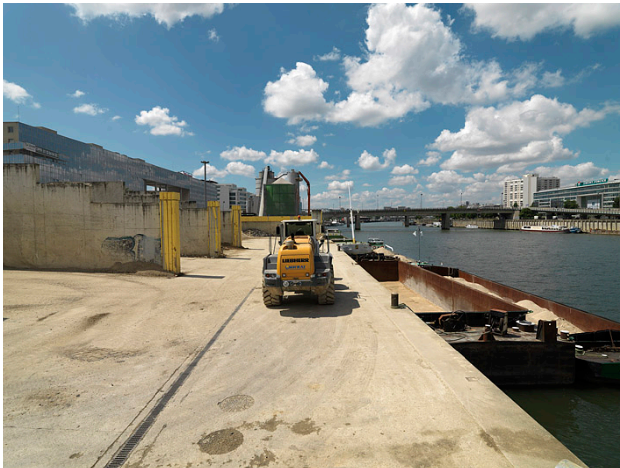
Ivry-sur-Seine. Vue du quai et des espaces de stockage des sables et gravillons.
