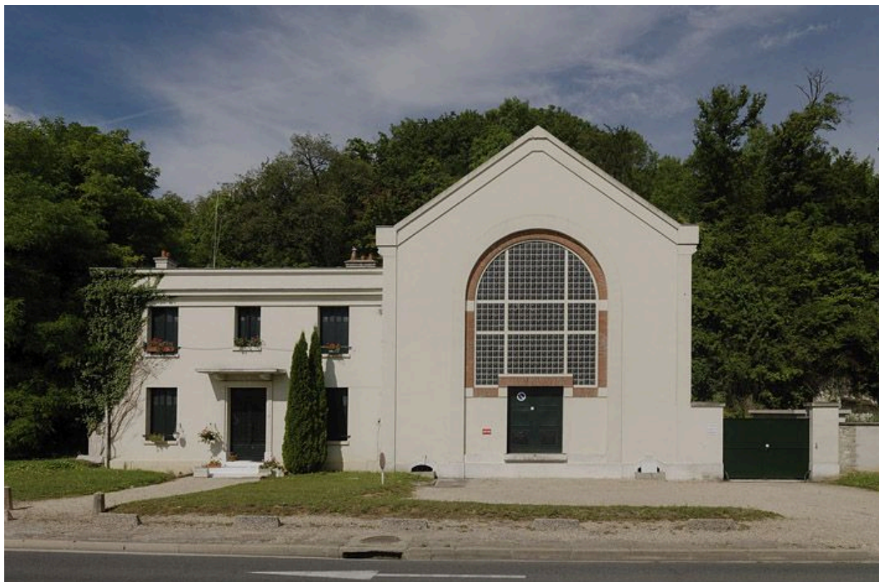
Station de pompage et logement de contremaître.
