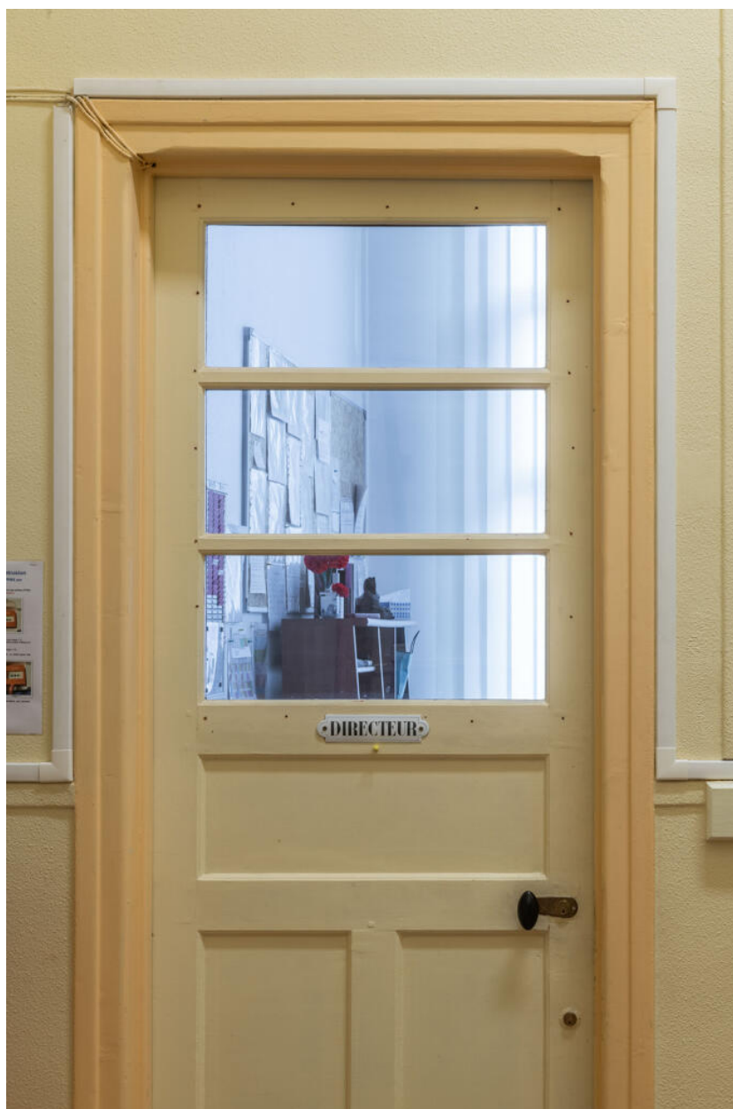
École des Coteaux, bâtiment de 1938, porte du bureau du directeur
