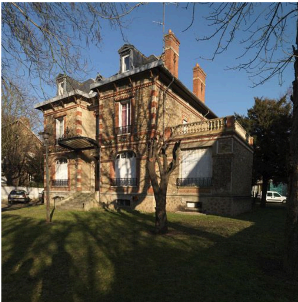
La maison vue de trois quarts (à partir de la terrasse sud).
