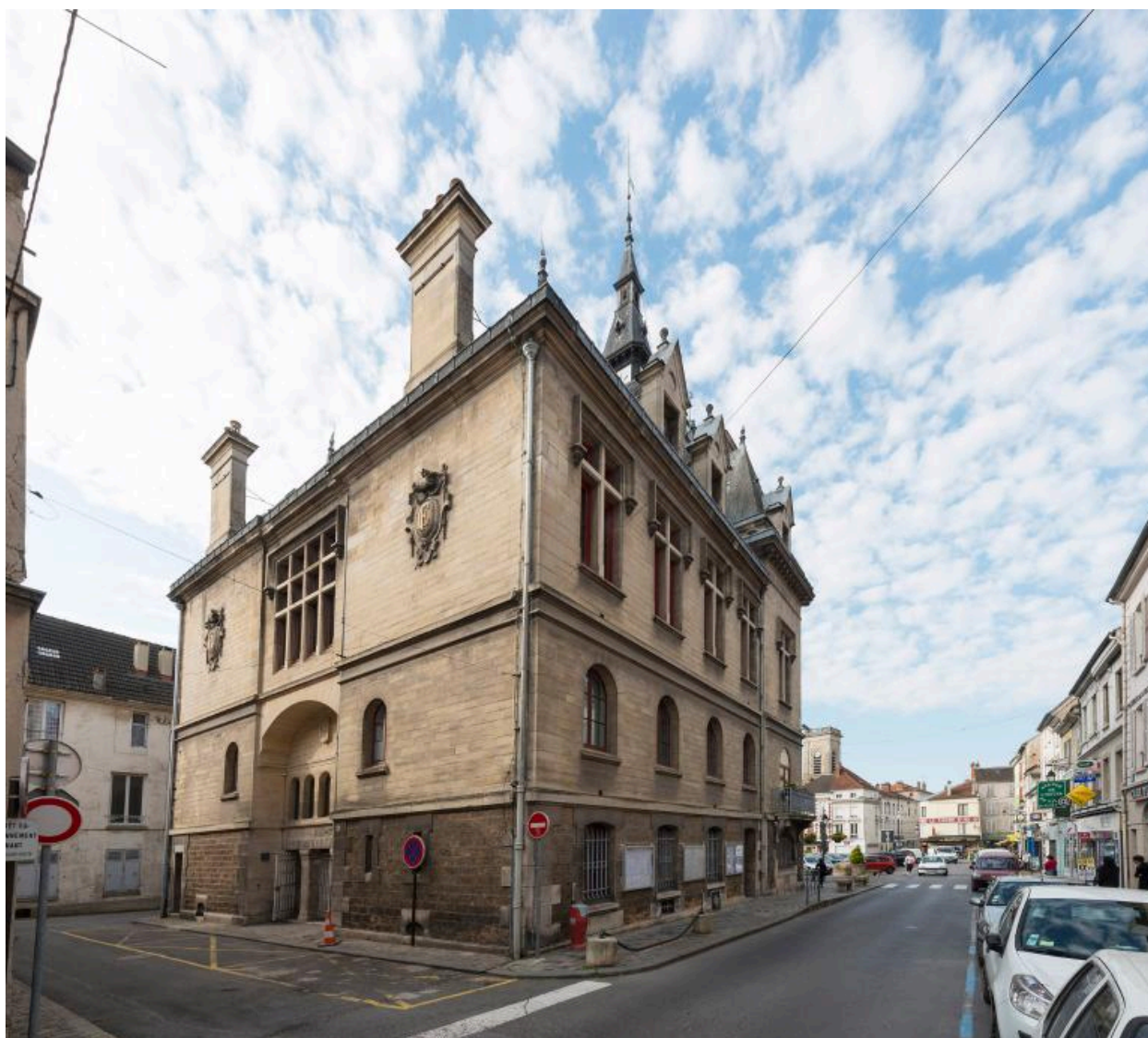
La façade postérieure et l'élévation latérale nord.
