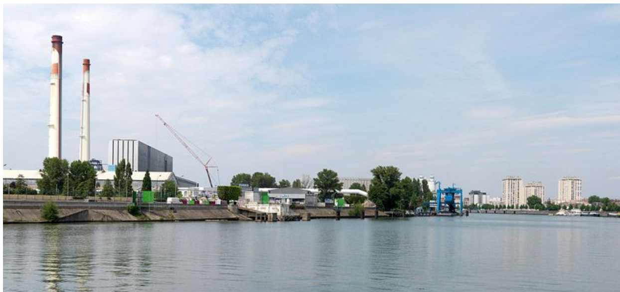
Vitry-sur-Seine, paysage. La Seine, au premier plan l'ensemble de la centrale thermique.
