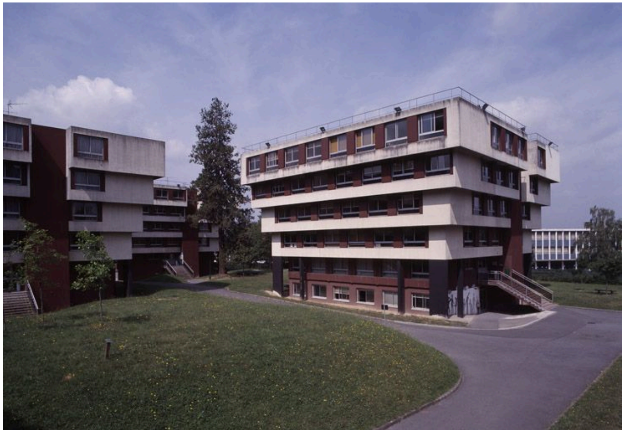
Ecole internationale européenne de Paris : vue d'ensemble des trois "pyramides" édifiées dans le parc, à proximité du château.
