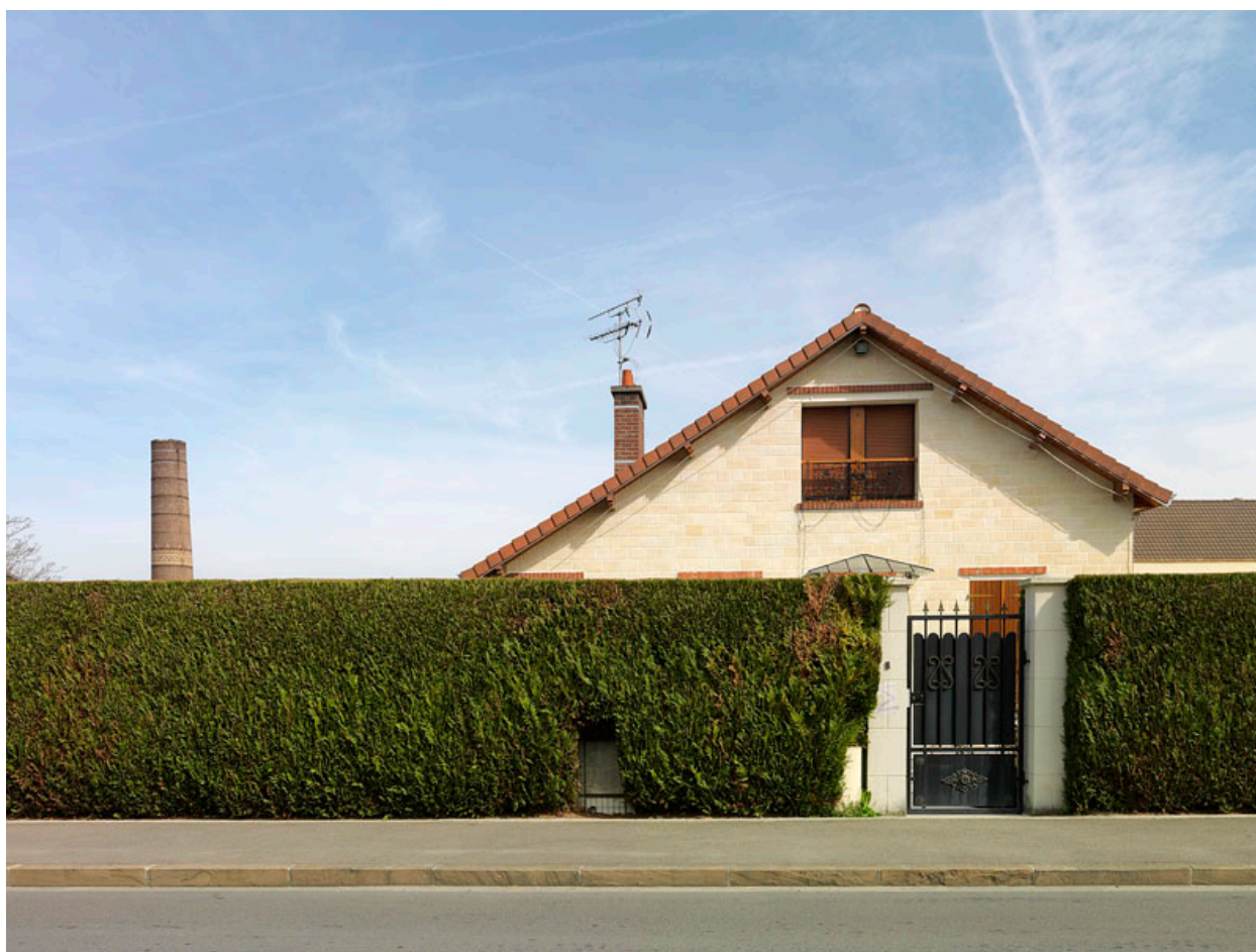
Asnières-sur-Oise. Rue dans une zone pavillonnaire. Cheminée de l'ancienne usine Vulli.
