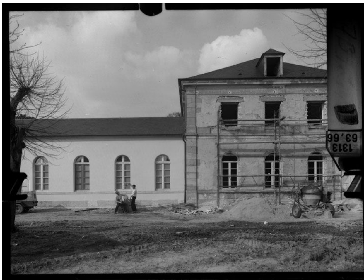
Pavillon en cours de restauration.
