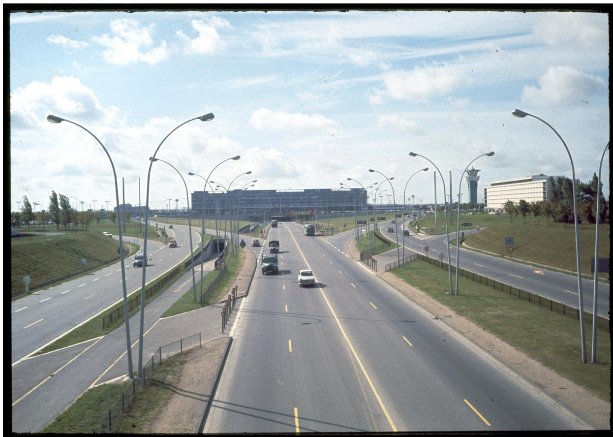
1967, les Installations Terminales vues depuis le nord.
