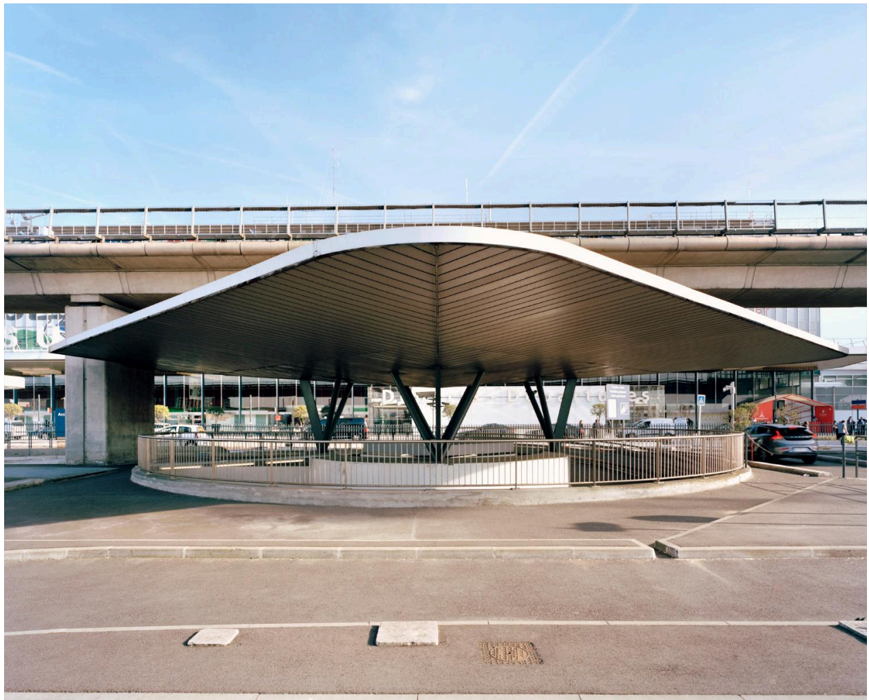
2018, entrée du parking P4a sous la station d'Orlyval Orly-Sud, vue prise depuis le sud.
