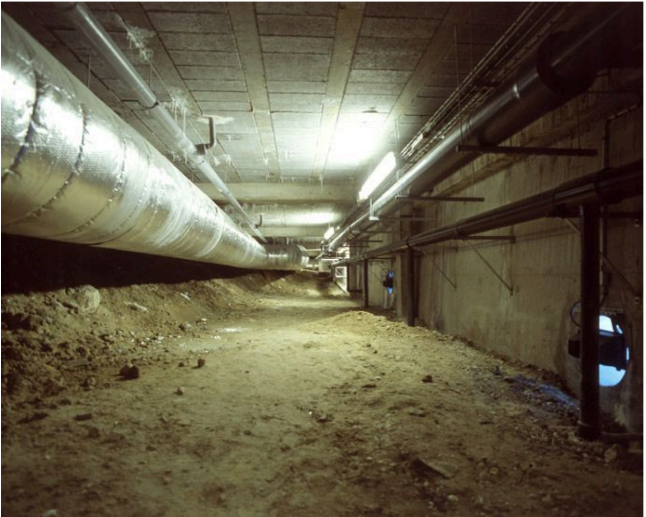
La piscine couverte : galerie de circulation souterraine, le long des cuves des bassins.
