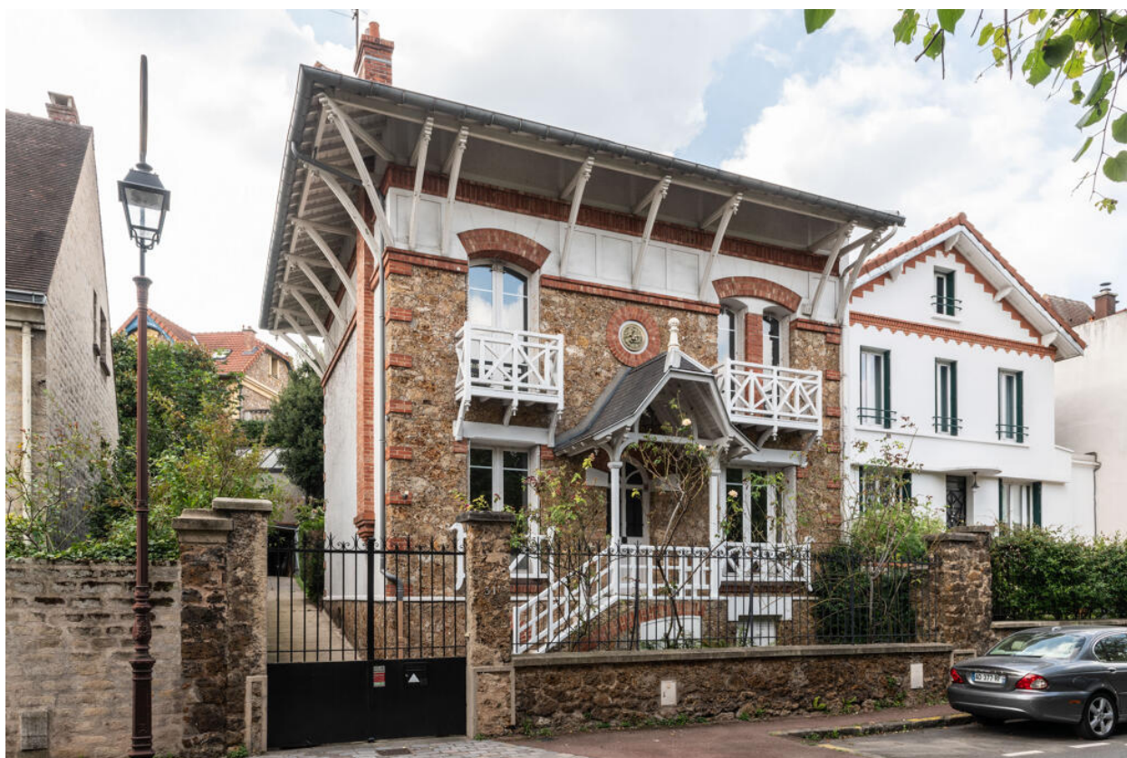
Pavillon du coteau de Saint-Cloud présentant les caractéristiques ornementale de l'architecture de villégiature
