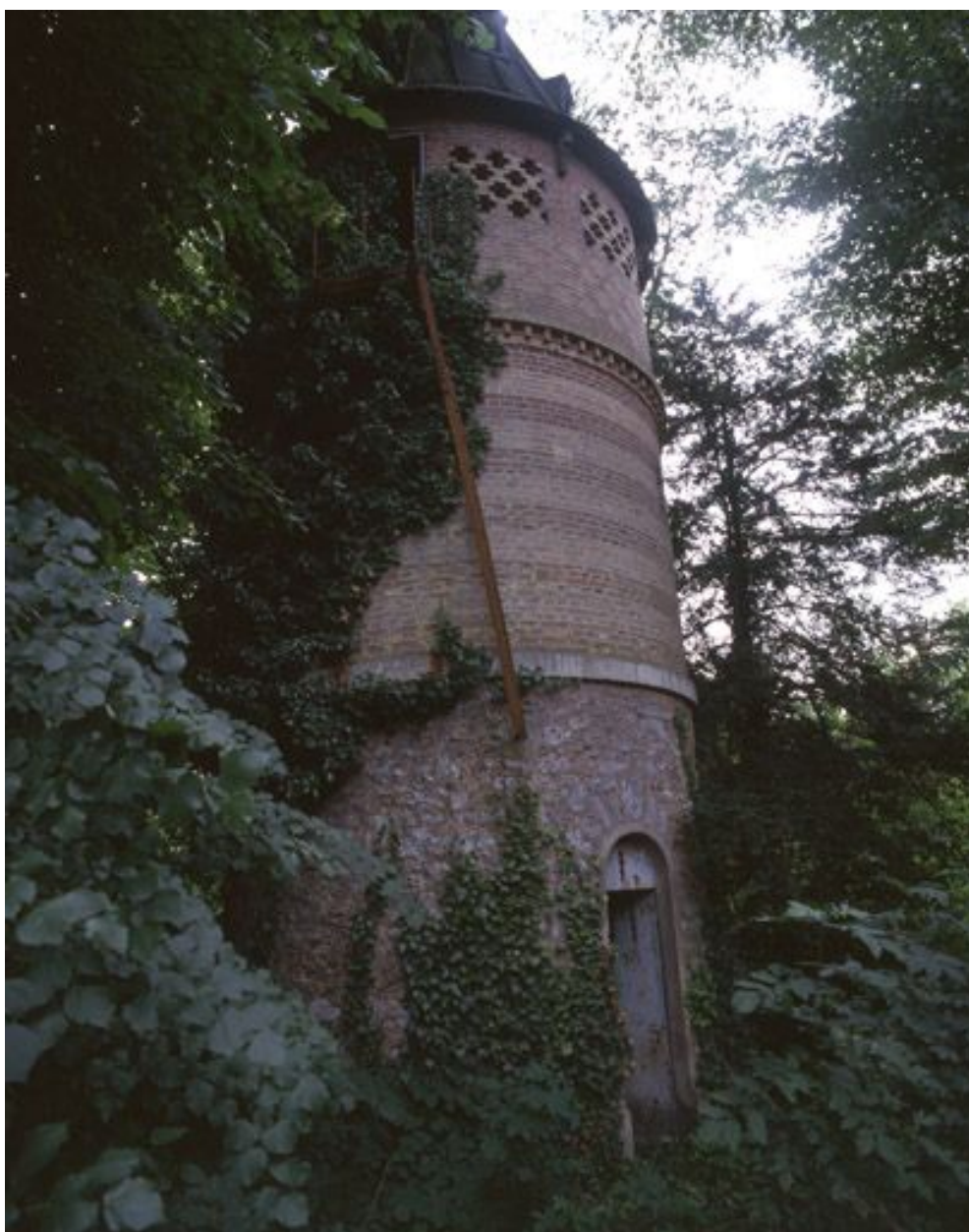
Vue rapprochée du château d'eau.
