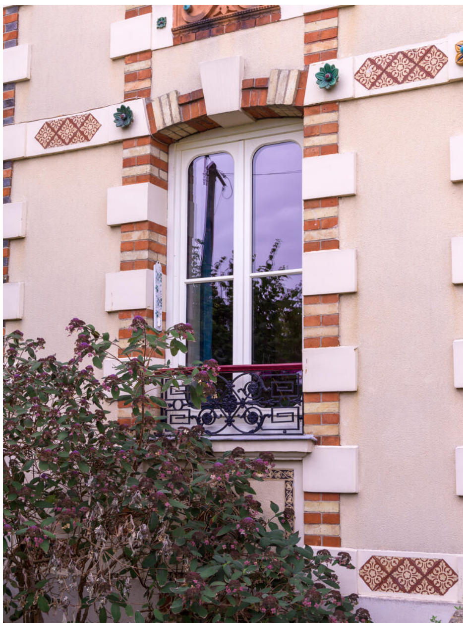
Vue de la façade nord, détail du niveau bas d'une travée.
