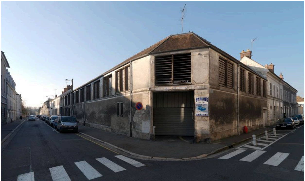
Vue générale de l'ancienne blanchisserie industrielle.
