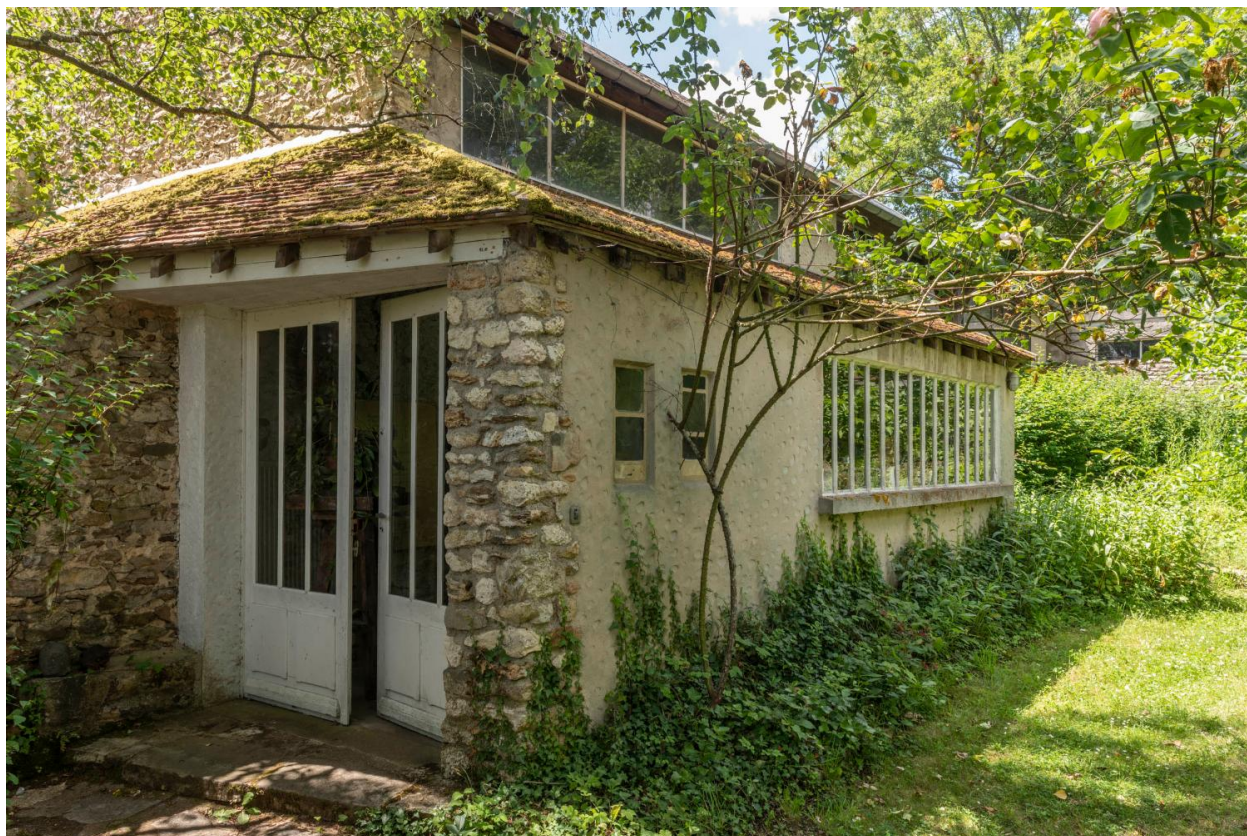
Entrée de l'atelier
