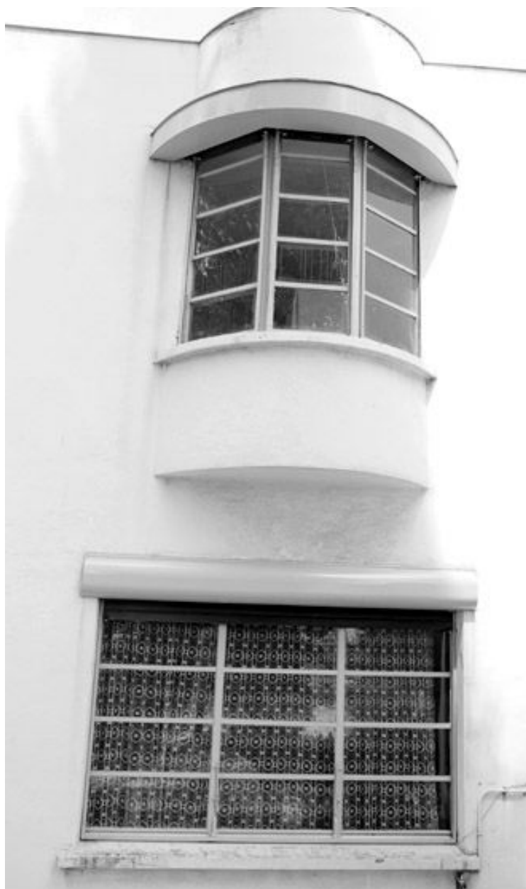
Détail de la façade sur cour.
