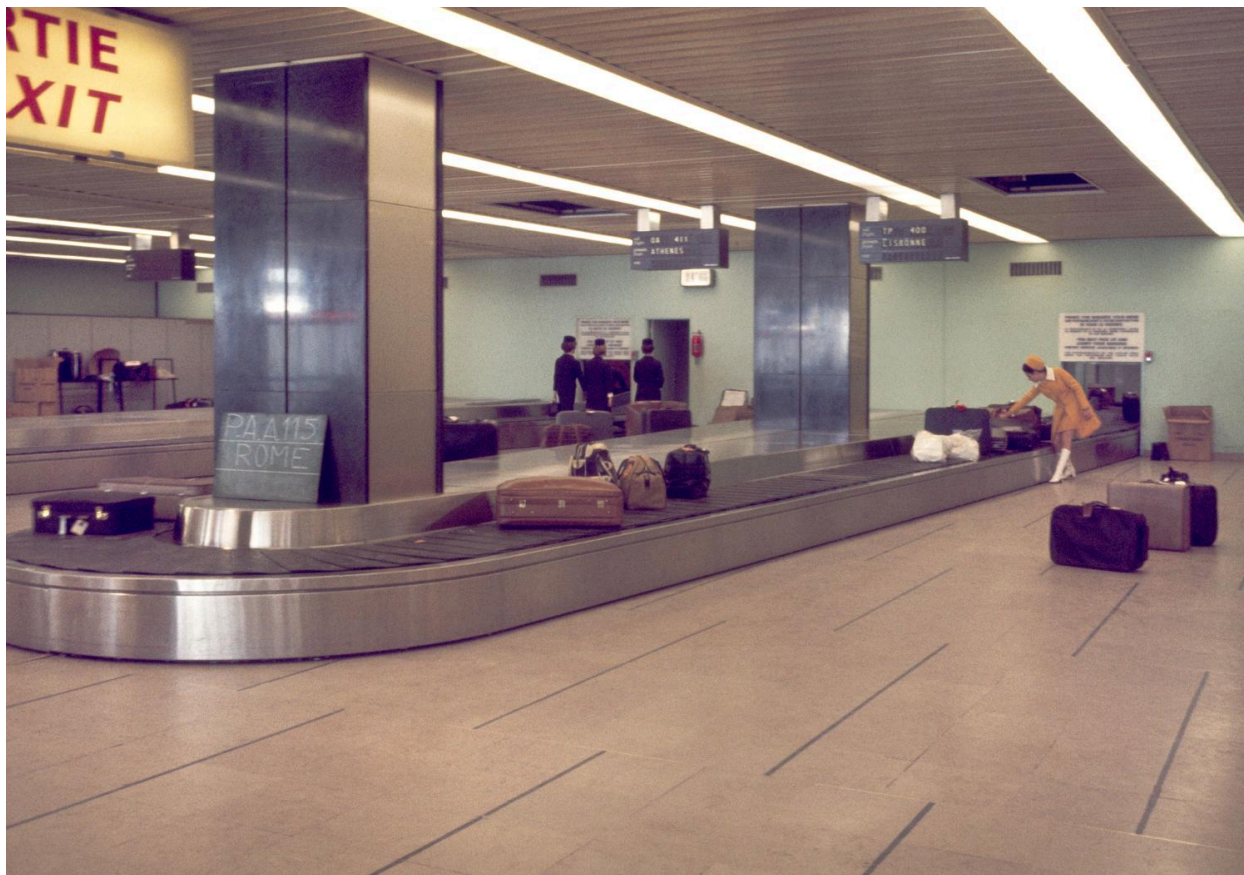
1971, livraison des bagages, rez-de-chaussée coté arrivée.
