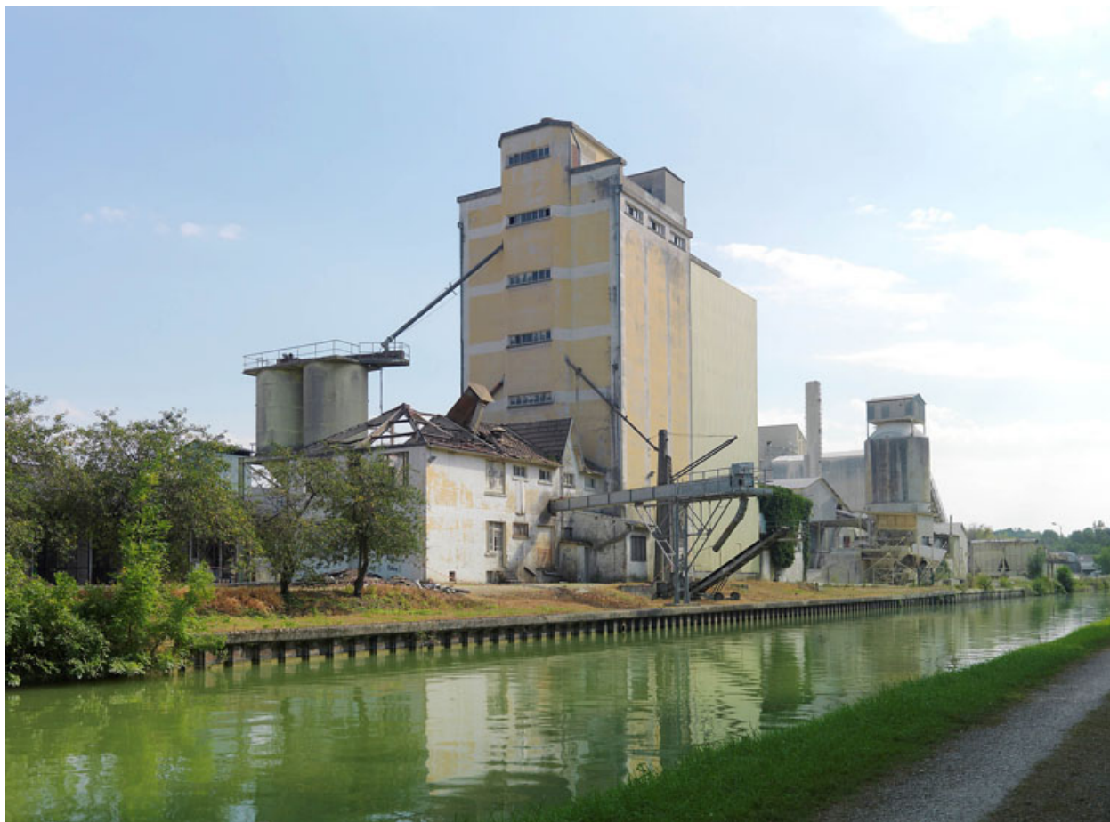
Silo vu du canal du Loing.
