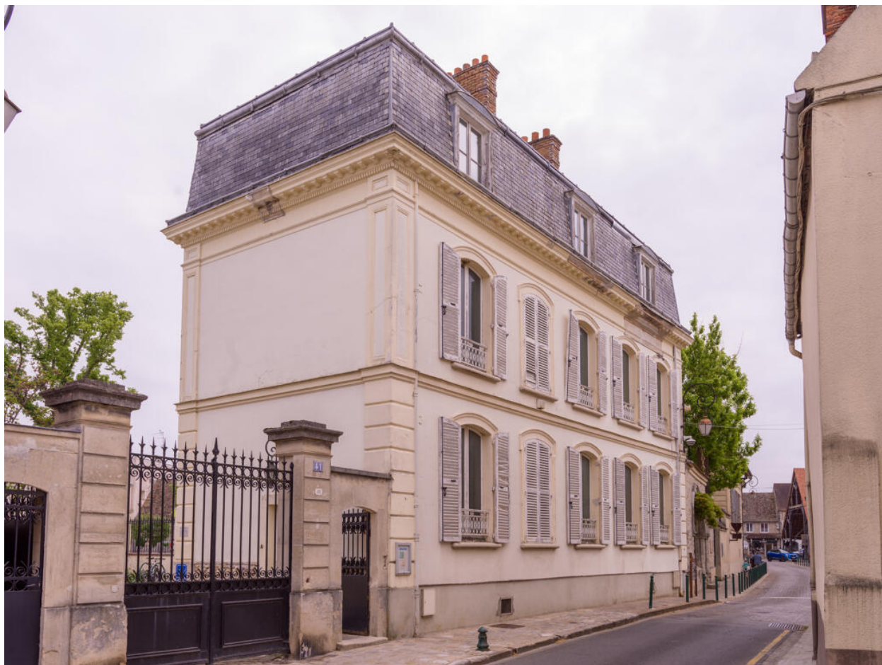
Vue générale depuis la rue Langlois (depuis l'ouest).
