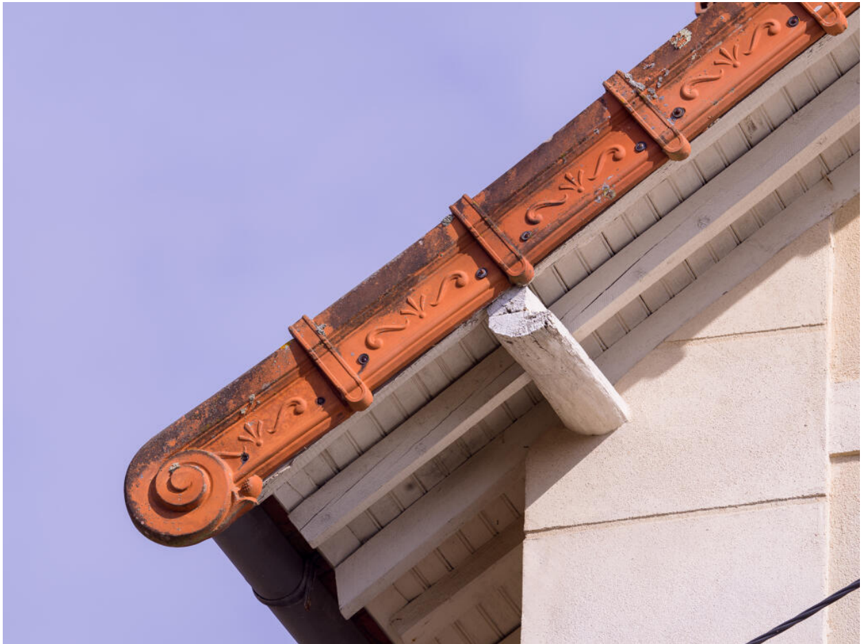
Vue de détail des tuiles de rives et de l'acrotère.
