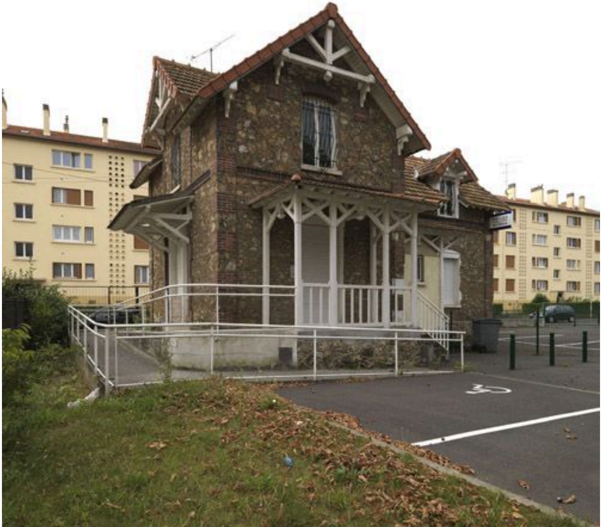
Façades antérieure et latérale du corps principal.
