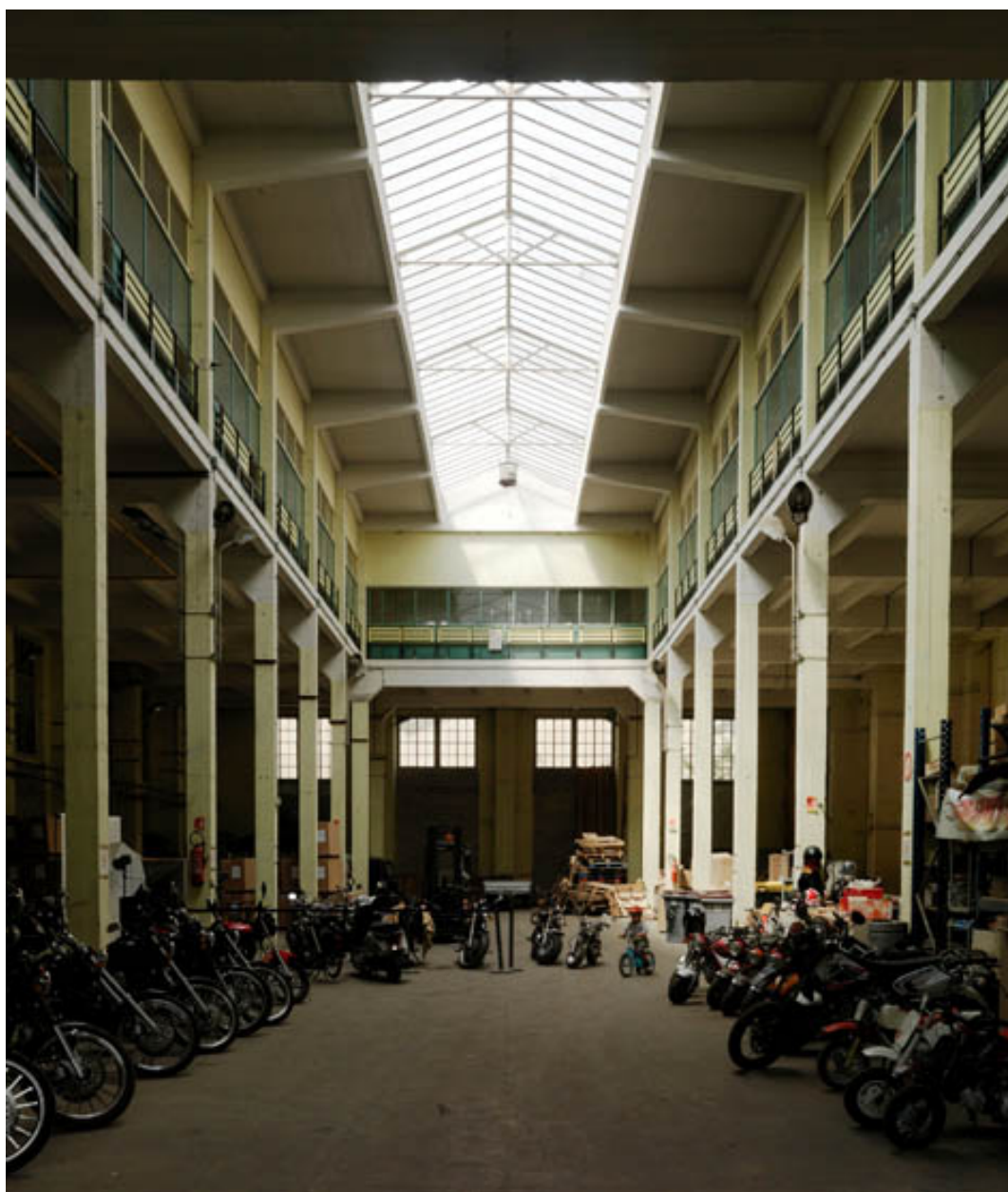
Vue intérieure du magasin général (1915). Structure en béton.
