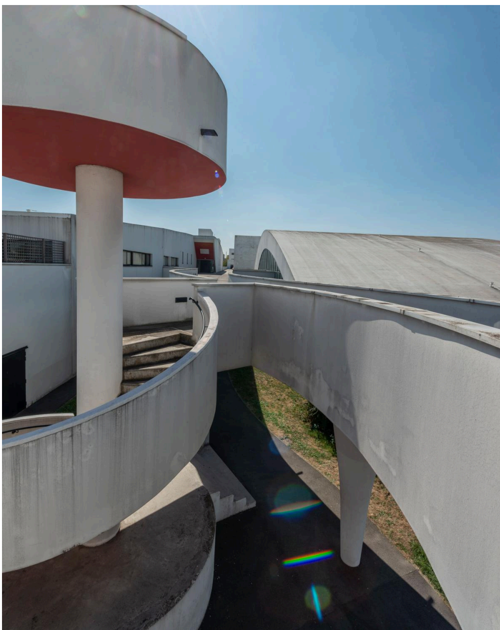
La rue intérieure et le péristyle.
