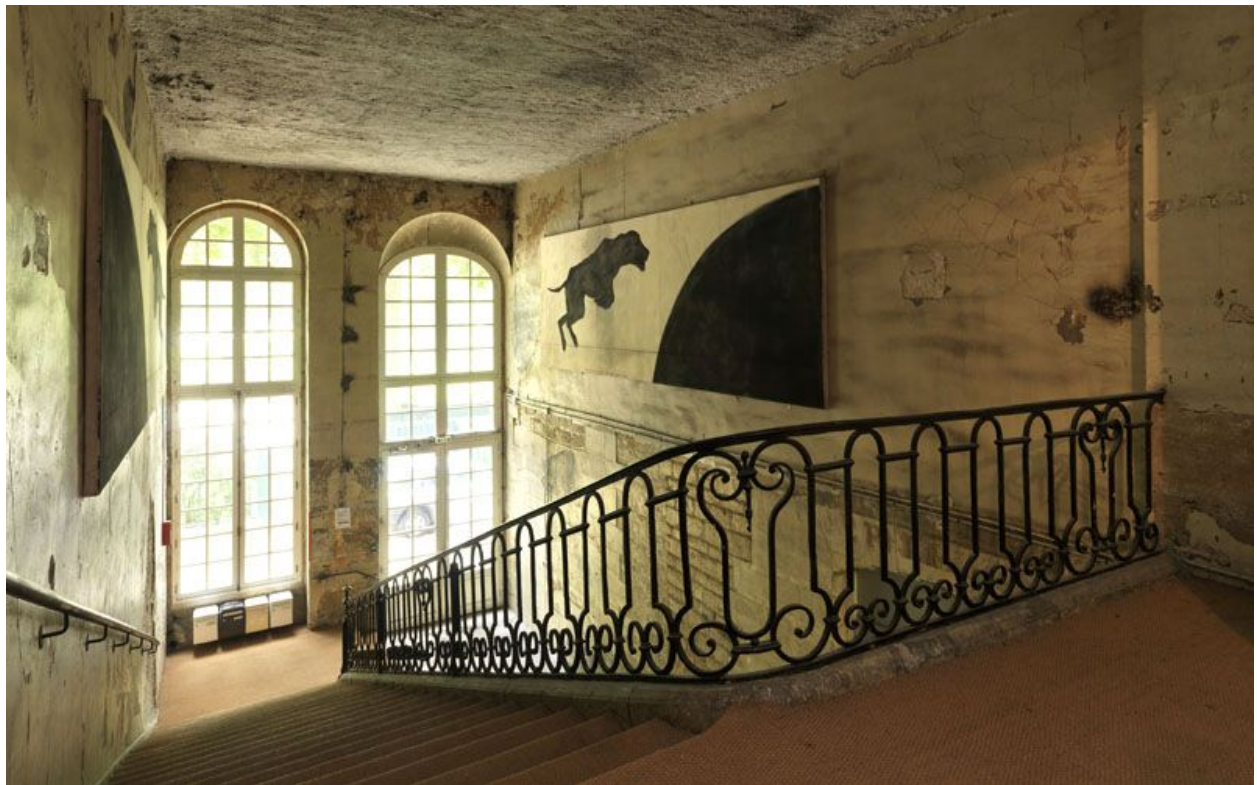
Vue de la rampe depuis le palier.
