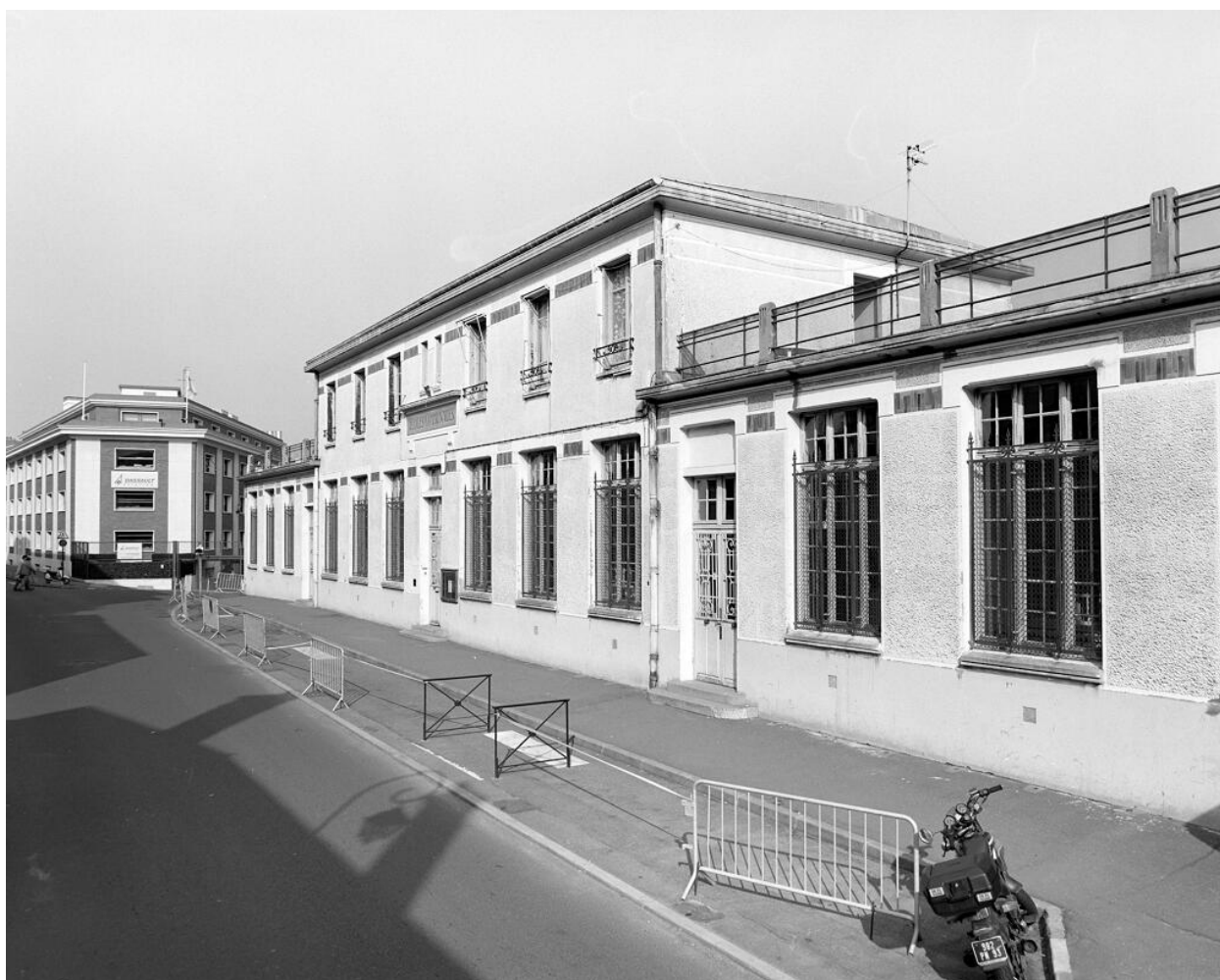
Vue d'ensemble des façades sur la rue.
