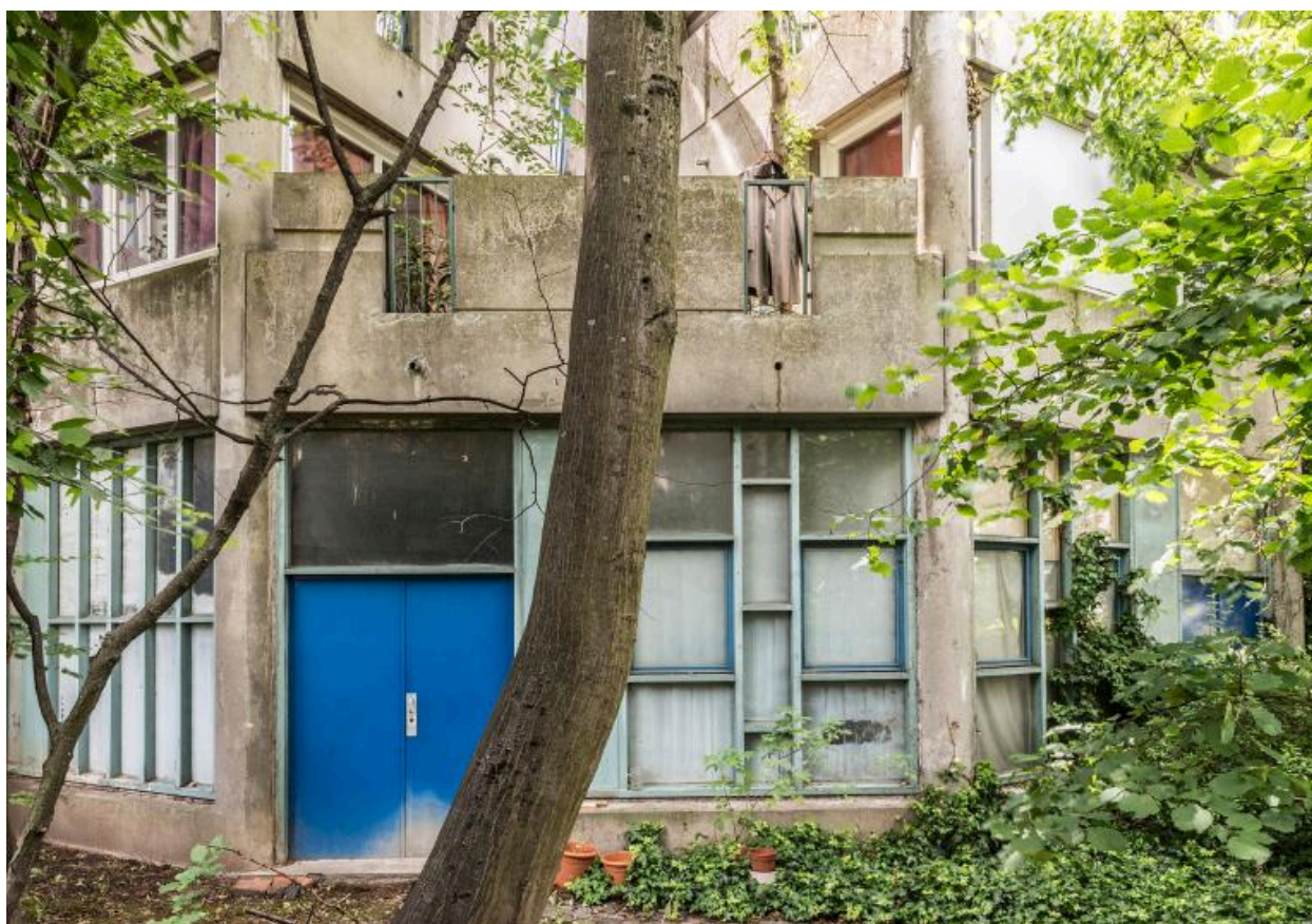
Vue de la verrière d'ateliers d'artistes au rez-de-chaussée, allée Nicolas de Staël (6)
