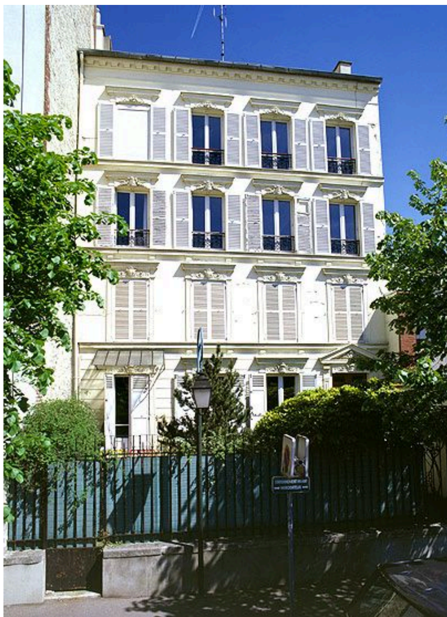
Immeuble, 8 place Pierre Sémard. Vue d'ensemble.
