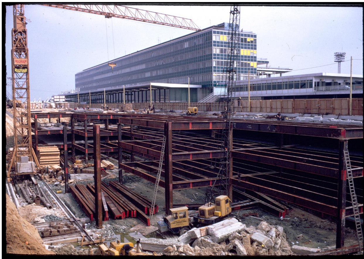
28/04/1968, construction du parking souterrain P1.
