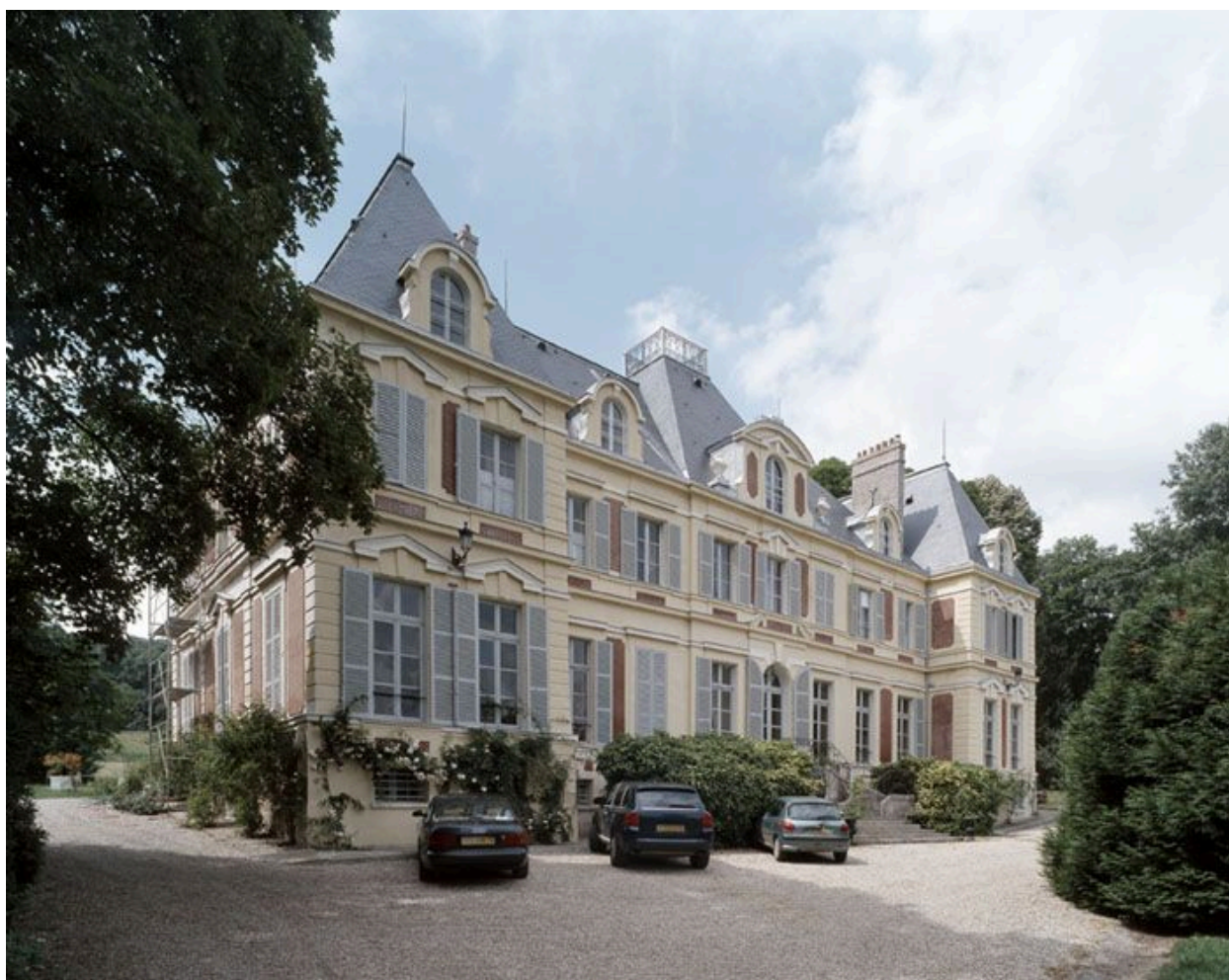
La façade antérieure du château.
