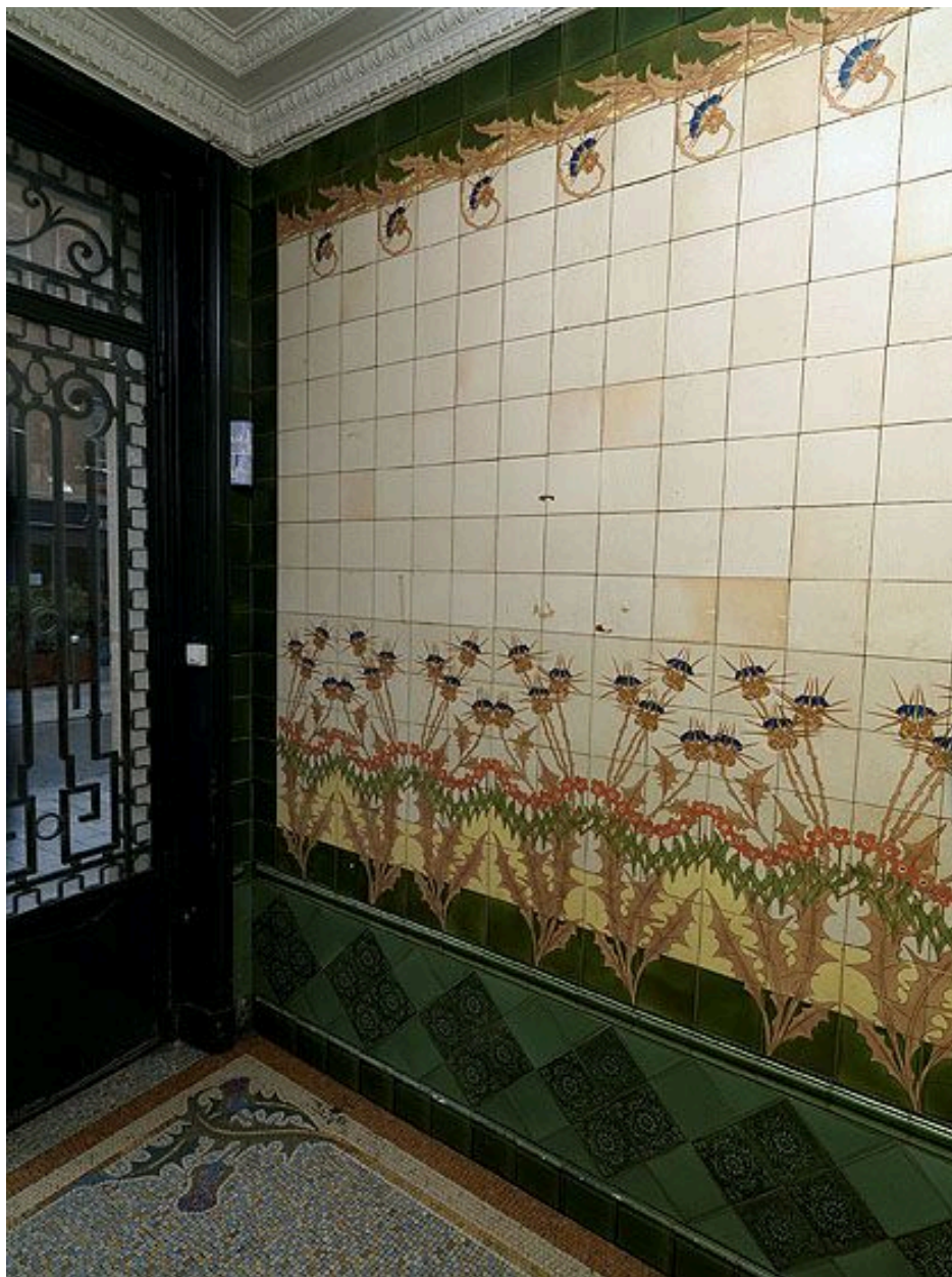
92, Suresnes, immeuble, 36 rue Emile-Zola. Décor de faïences de Sarreguemines de l'entrée de l'immeuble.
