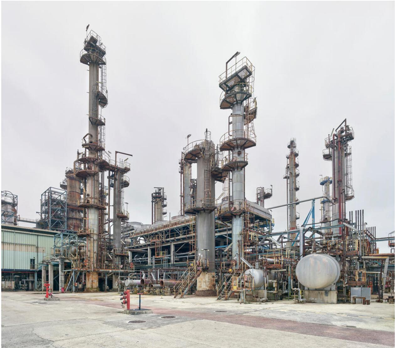
Unités Est - FCC (Unité 651). Traitement des gaz à la DEA. On absorbe le dihydrogène (H<sub>2</sub>S) contenu dans les gaz par lavage.
