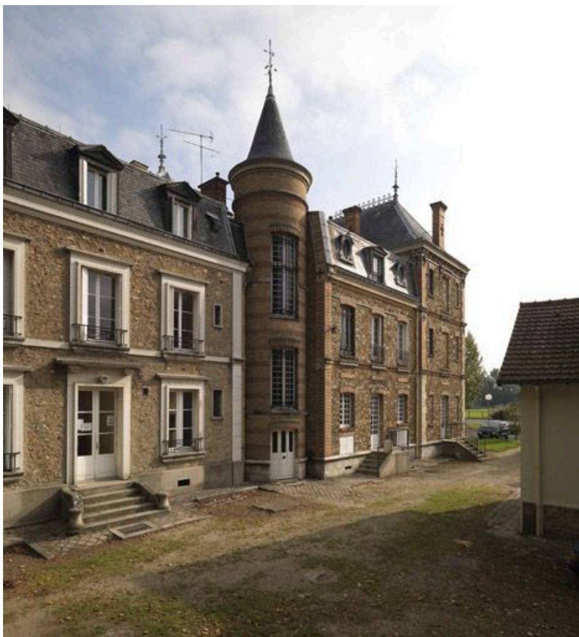
Vue de la façade sud-ouest.
