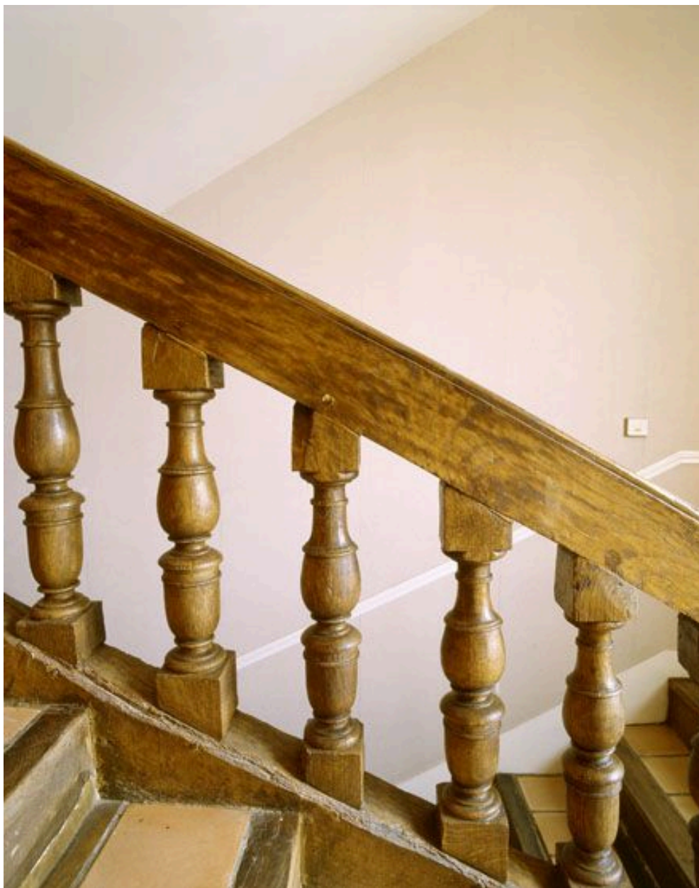
Détail des balustres.
