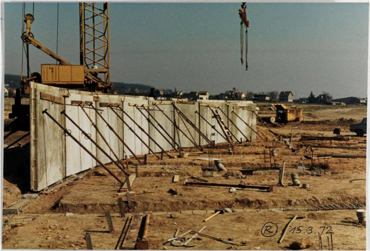
La Noé. Photo du chantier en 1972. On observe la mise en place de panneaux préfabriqués en RDC. (Cité de l'architecture et du patrimoine, Archives d'architecture du XXe siècle).
