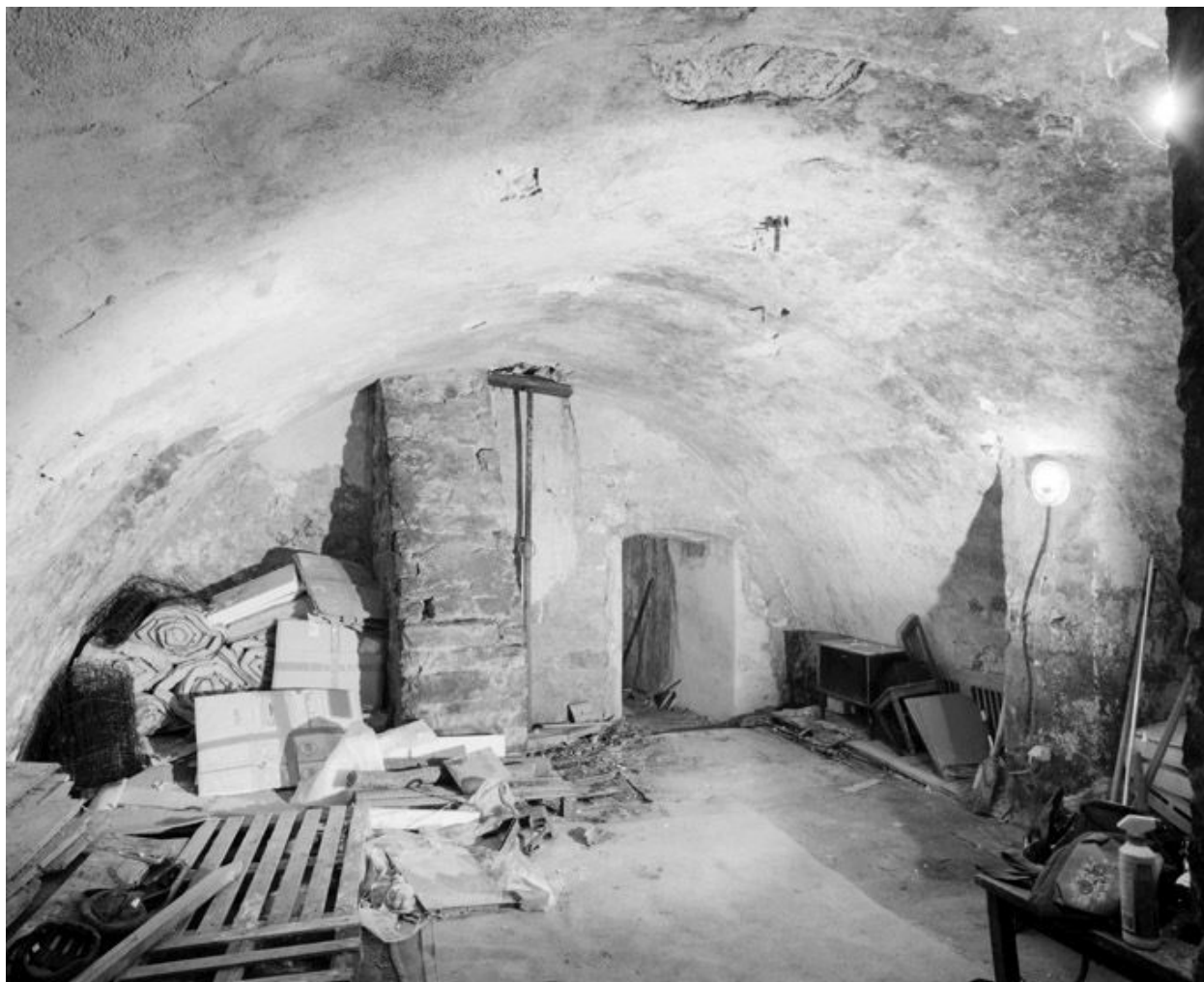
Partie nord de la cave, voûtée en berceau (17e-18e siècles?). Vue prise depuis le nord.
