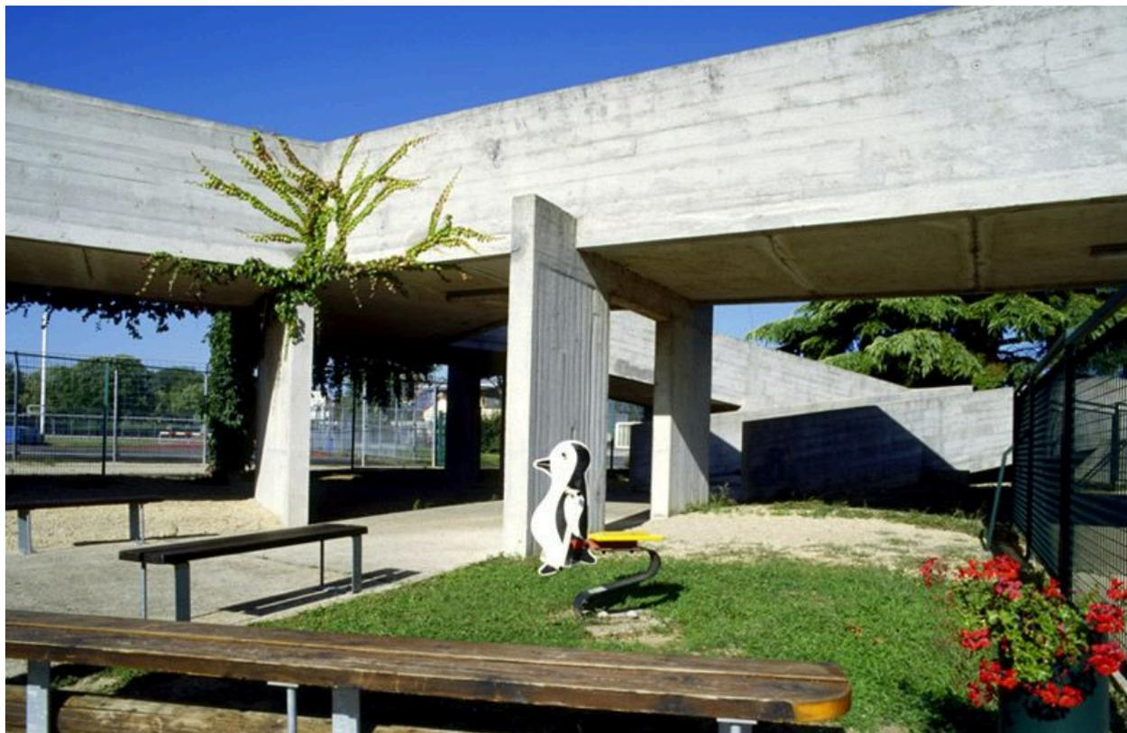
La rampe d'accès au bassin découvert, en béton brut de décoffrage.
