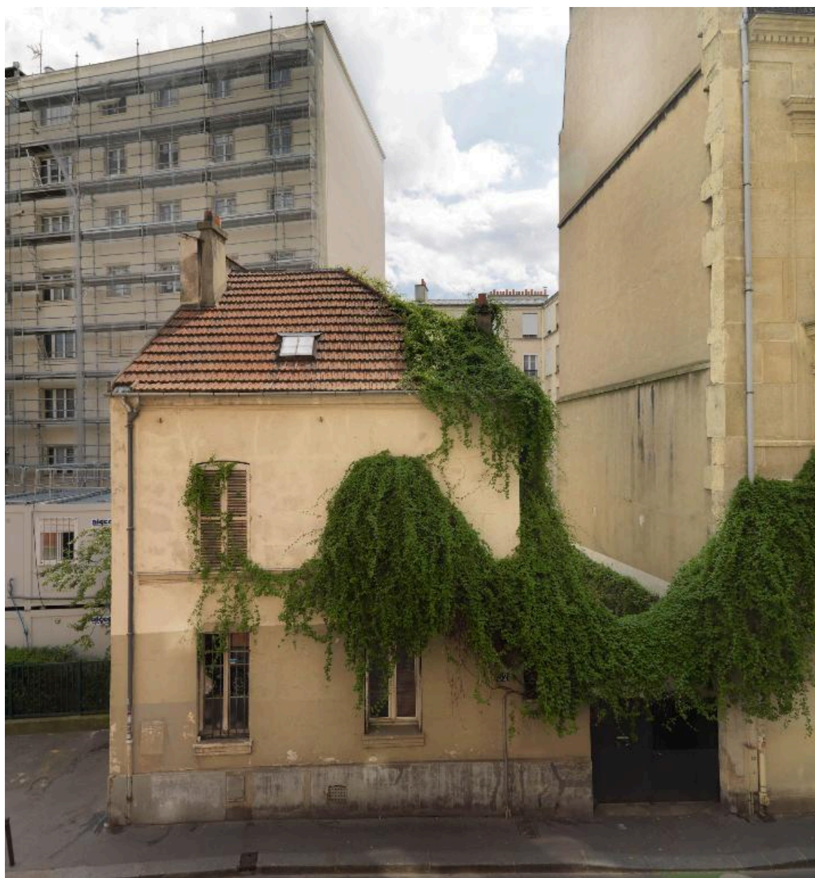
Entrée du 32 rue de Toul (2)
